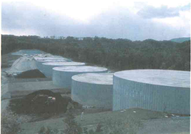
現場に立ち並ぶ巨大な円柱。直径33.8m、高さは7~10mに達する。大部分は将来土で覆われ緑化される
