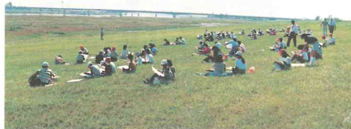
丘陵堤（石狩市） 石狩川の下流部は地盤が軟弱なため、通常の堤防では、それ自体の重さで沈んでしまいます。そこで、この沈下を防ぐために、堤防の斜面を緩やかにし、底面積を広くしたのが丘陵堤です。緑が多いこの堤防は景観にも優れ、人々が水と親しめる空間となっています。
