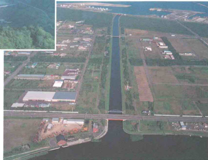
石狩放水路（石狩市） 札幌市北部地区は、低平地のため茨戸川の氾濫による被害を受けやすい地域です。この放水路は茨戸川の洪水を直接日本海に放流するためのもので、昭和56年の洪水時には工事中でしたが緊急的に通水を開始し、流域の被害を軽減しました。
