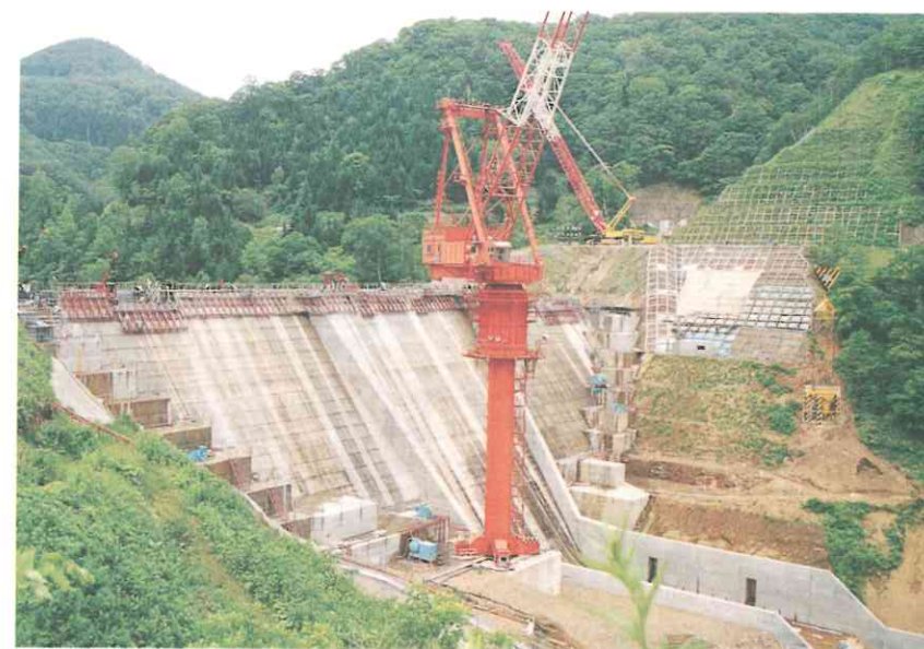
ほぼ完成している提体です。写真左側に水を貯め、右側が用水路につながります。山の斜面には、できるだけ緑を戻そうと、植物を植えています。
