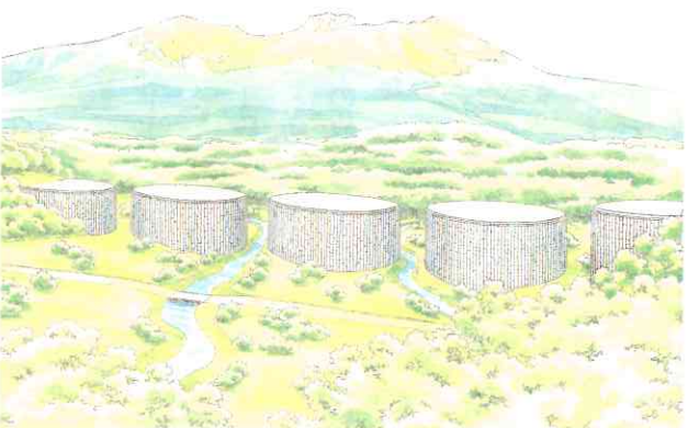
完成予想図。川の流れを妨げないように隙間が開いている
