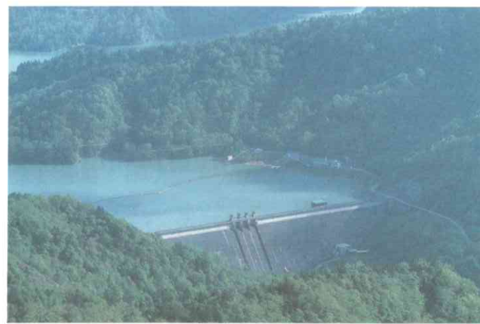
桂沢ダム（三笠市） 幾春別川の洪水被害の軽減、農業用水と水道水の確保、発電などの目的で建設された桂沢ダムは、北海道で最初の多目的ダムです。昭和26年に着工し、32年に完成しました。
