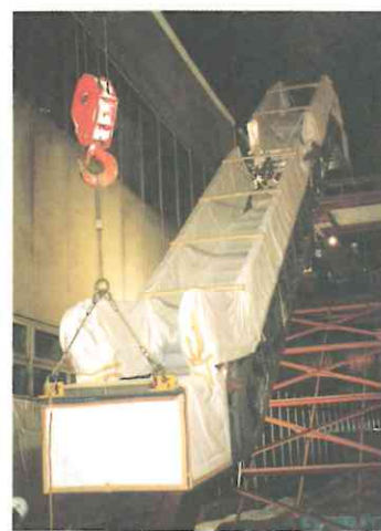
工事時間を短くするために、エスカレーターを組み立ててから搬入します。
