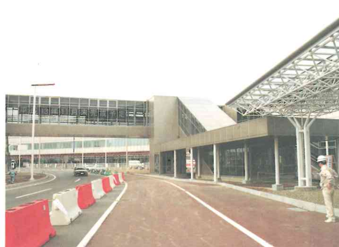
北側の連絡橋です。外観はほぼ完成しています。
