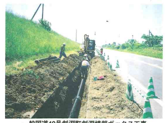
一般国道40号剣淵町剣淵情報ボックス工事
