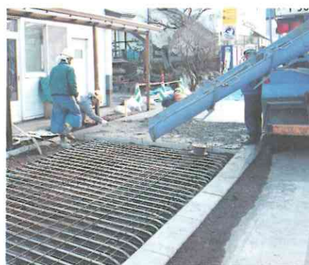
工事の様子です。このヒートパイ プに温泉の熱が伝わり、雪を溶か します。ヒートパイプは、区間全 体で13,000本が埋め込まれていま す。
