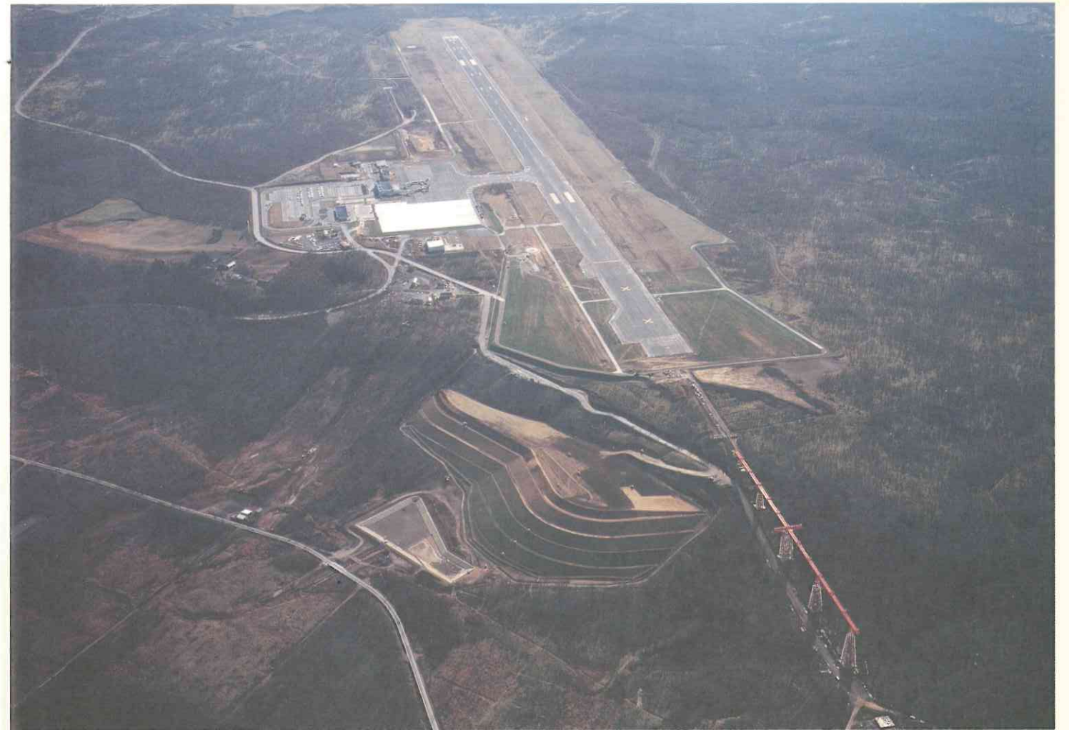
昭和59年滑走路延長事業（1,800m→2,100m）北側盛土工事盛土の高さは50mにもなっています
