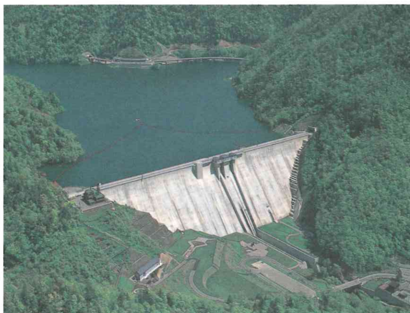
重力式の定山溪ダム
