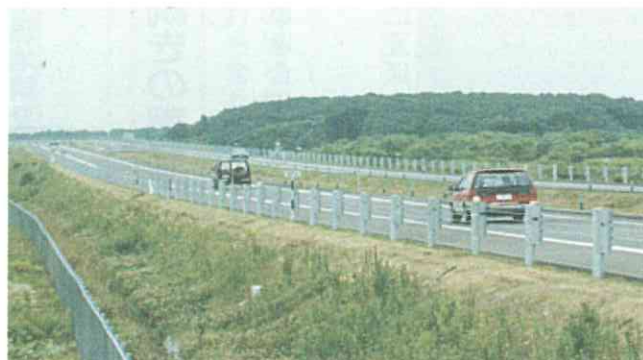
日高自動車道 ガードロープを設置しているため走りやすくなっています。
