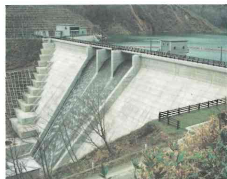
140万トンの水を貯え試験放水する大野ダム
