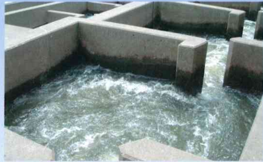
魚道のプール部
