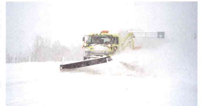
日勝峠の除雪作業
