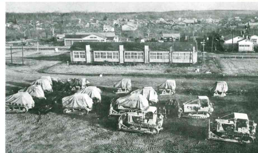
パイロットファームの「かなめ」となった合同庁舎※
