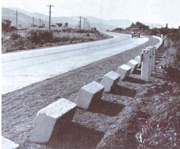
昭和30年に舗装が完成
