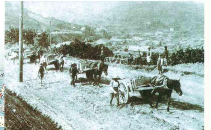
馬車による路面敷碎石の運搬状況 (明治9年)「札幌国道写真帳」より
