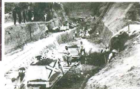
昭和9年完成工事・朝里付近の切割
