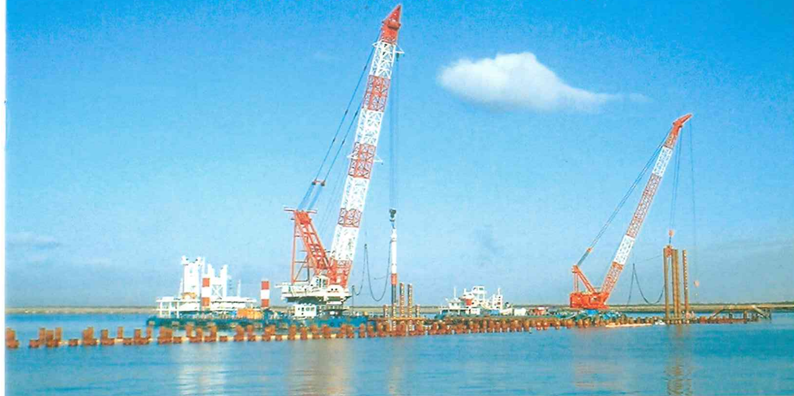
建設中の苫小牧港東港区多目的国際ターミナル全景
