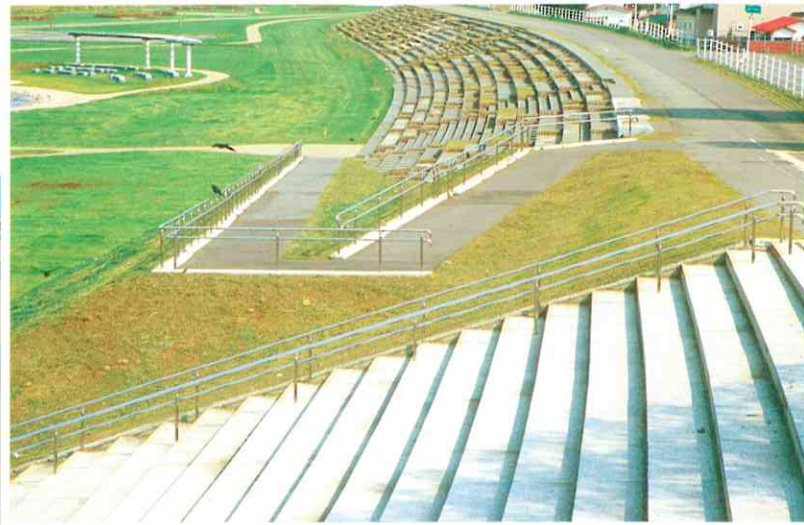
河川敷へはスロープと階段で降りられます スロープは、勾配を緩くすることで誰もが利用しやすい形状としました。安全面から手すりも設置していますが、子供から大人までが利用可能なように段違いのものを取り入れています
