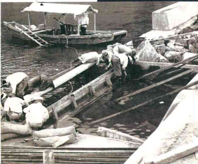
防波堤建設工事の様子（昭和27年頃） 増毛町 提供
