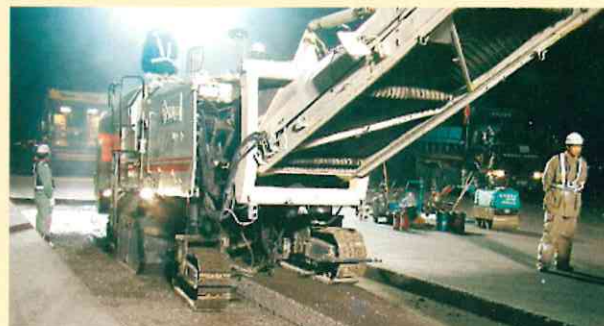
夜の間に工事を進めています。
