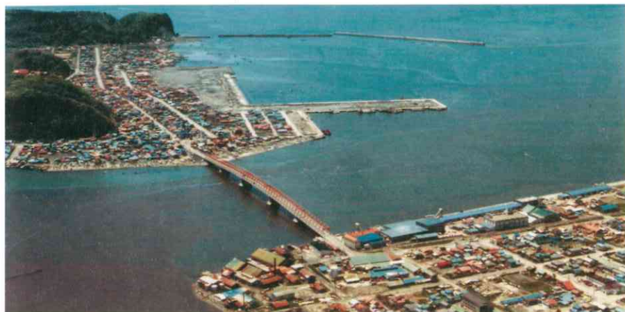
厚岸漁港 (中央の橋は厚岸大橋) 昭和56年
