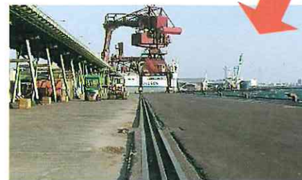
十勝沖地震後（平成15年9月） 液状化対策などが効果を発揮し、被害はほとんど見られません
