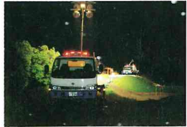
夜間の復旧作業を支援する照明車
