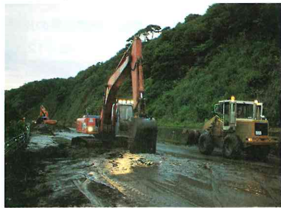
通行規制の解除に向けて、道路を覆った土砂の除去等を行いました（一般国道235号厚賀）
