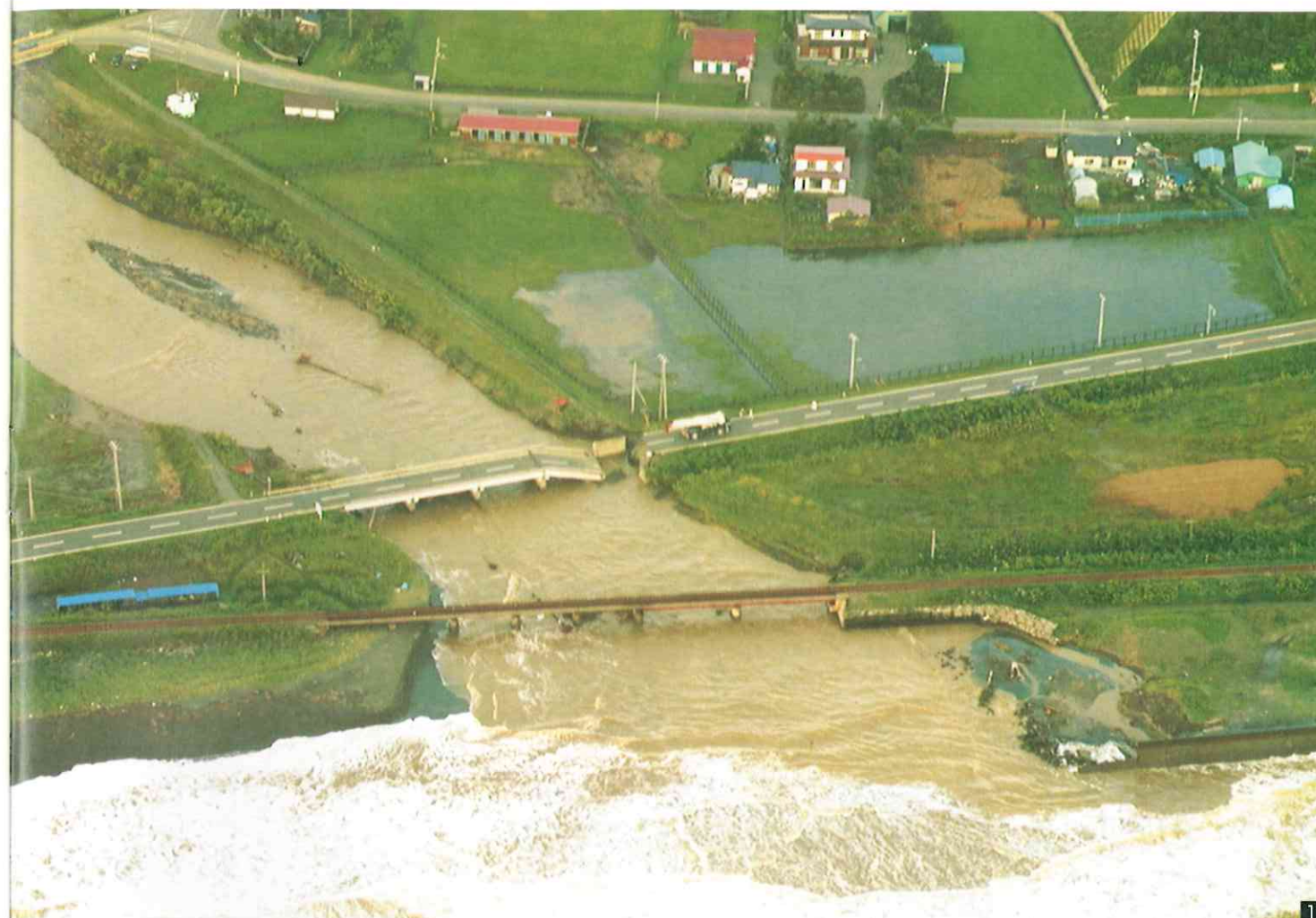
河川の増水により橋台部分の土砂がえぐられ落下した橋（一般国道235号 慶能舞橋）
