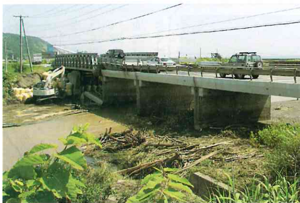
慶能舞橋は、応急復旧橋を架設して、8月12日14時に通行可能となりました。これをもって、国道の全箇所通行止めを解消しました
