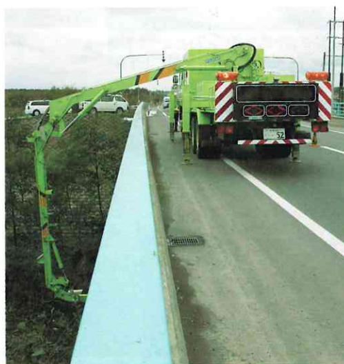
橋梁の点検状況。2台の橋梁点検車で、9月27日から30日にかけて、各地の橋を点検しました(一般国道38号 下頃辺橋)
