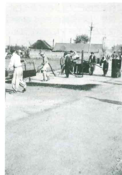
アスファルト基礎工事の様子：道路情報館所蔵
