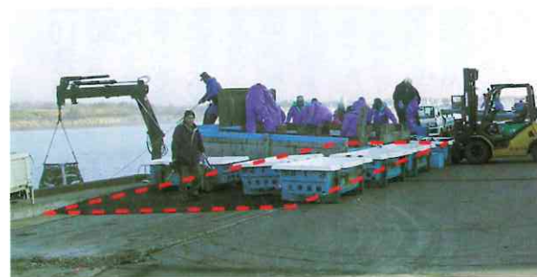
復旧工事が終わり、サケの水揚げを再開した大津漁港。赤点線が被災箇所。岸壁が、最大で約10cm沈下しました
