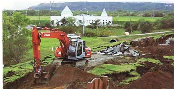
河川堤防の応急復旧状況(十勝川 大津築堤)
