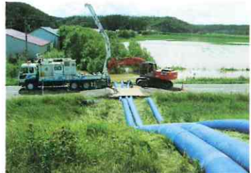
内水排除作業を行う排水ポンプ車
