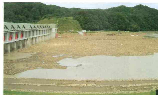
大量の流木をせき止め、下流域の流木被害を軽減した二風谷ダム。せき止めた流木量は、通常流れ着く量の約67年分に相当します
