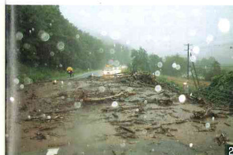
土砂が流れ込み通行止めとなった国道（一般国道241号 足寄町上足寄）
