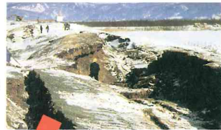
釧路沖地震後（平成5年1月） 堤防が大きく沈下するなどの被害を受けました
