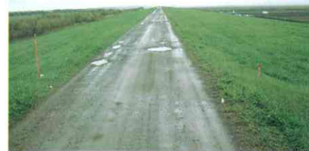
十勝沖地震後（平成15年9月） 基盤処理を実施した箇所では、被害はほとんど見られません
