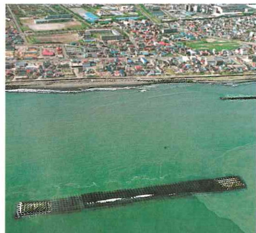
胆振海岸の沖合で整備が進む人工リーフ。周辺では、ホッキ貝やウニなどの生息が確認されています。
