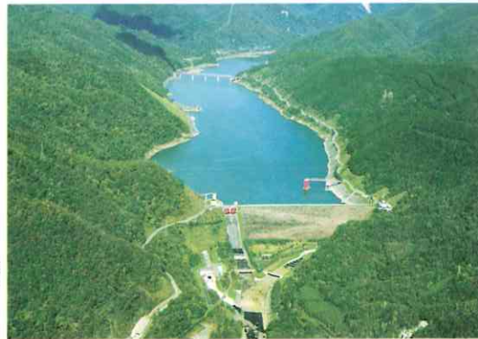
十勝ダム 十勝川の洪水調節と発電を目的に建設された流域内初の多目的ダムです。（昭和48年度着工、昭和59年度完成）
