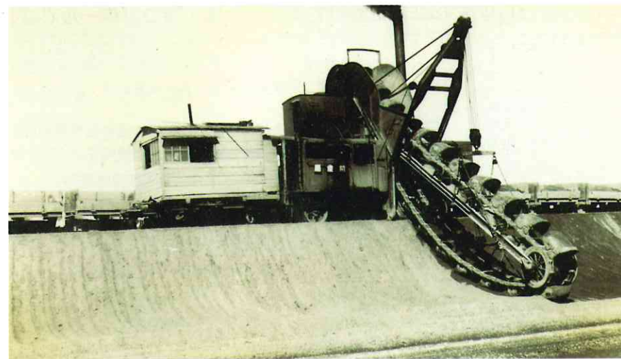
統内新水路の土砂掘削に活躍する蒸気機関車と掘削機
