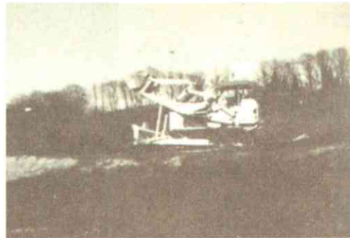
堤防の建設工事に活躍するブルドーザー 昭和40年ごろになると、様々な機械の導入が進み、機械が治水工事にかかせない存在になります。
