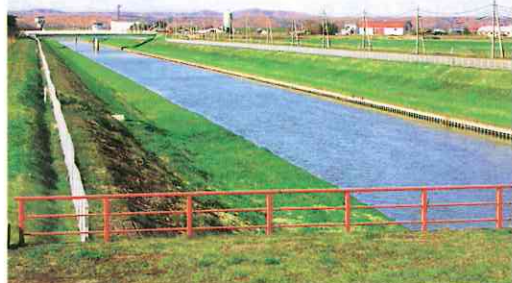
浦幌十勝導水路 浦幌十勝川の流量を一定に保ち、下流域の湿地化を解消する導水路。十勝川の水を、下頃辺（したころべ）川経由で浦幌十勝川に流します。（昭和51年度掘削開始、昭和57年度通水）
