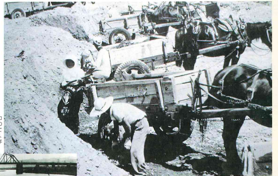
人力積込馬トロ運搬 人間が掘り、馬がトロッコを引き土砂を運搬するこの方法は、戦前戦後を通じて最も長い歴史を有しますが、土木機械の登場で昭和30年代前半で姿を消しました。
