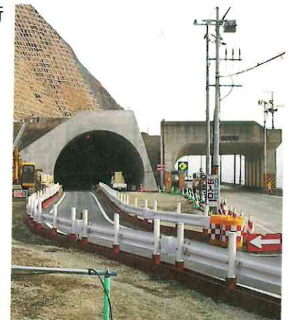
開通に向けて工事が進められている宇遠別トンネル（左側のトンネル）
