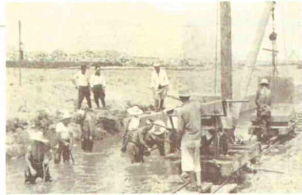
戦後間もない札内川の護岸工事 労働力、物資ともに極端に不足し、工事も応急措置程度のものでした。
