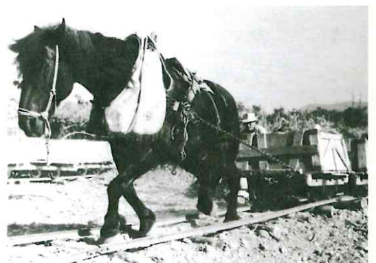
機械が普及する以前は、人力で土砂を掘り、馬にトロッコを引かせて運搬する方法で、工事が進められていました
