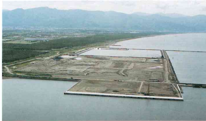
(左) 大型の作業船を使って鋼鉄製の管を打ち込み岸壁を整備しました (下) 整備中の多目的国際ターミナル上空写真
