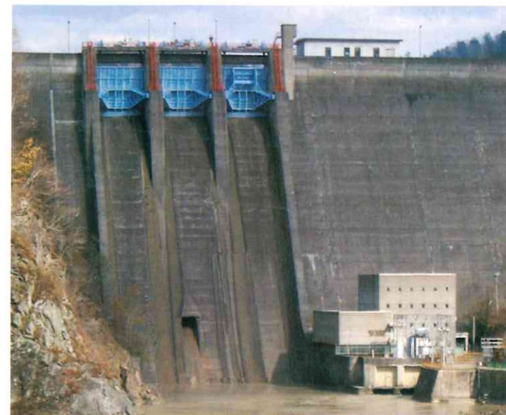
大夕張ダムと二股発電所(写真右下)
