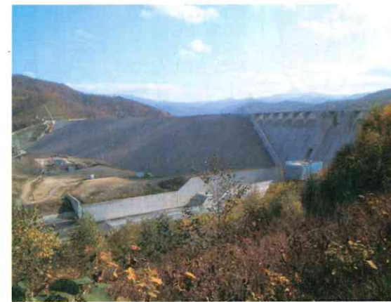
平成14年に完成したコンクリートダム部分(右)と昨年盛立が終了したフィルダム部分(左)の総長は885m、高さは86m。写真奥がダム湖に。右側は放流設備の工事中(平成16年10月)
