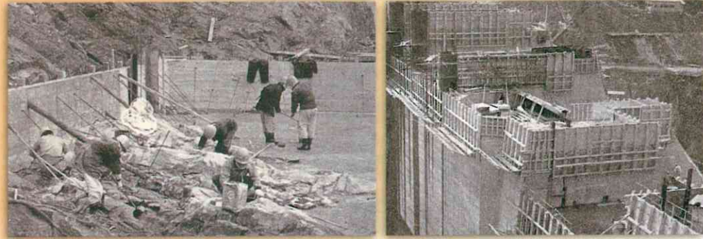
上段左 岩盤に穴を開ける作業 上段右 定礎石を前に記念撮影 下段左 岩盤清掃(昭和34年) 下段右 コンクリート打設が進む ダム堤体(昭和35年)
