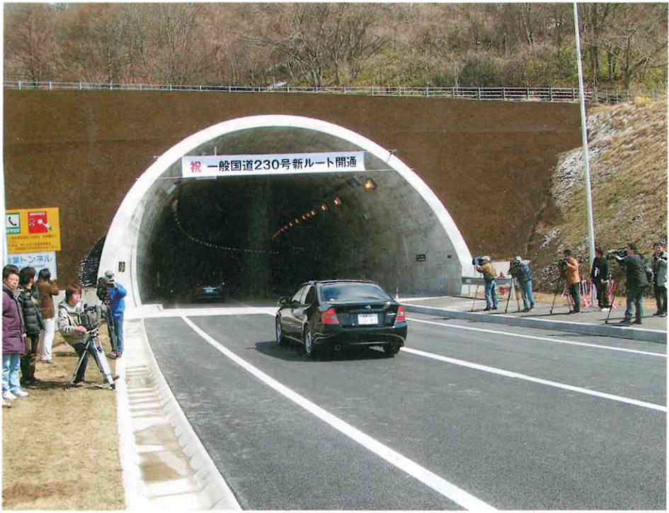
平成19年3月28日 開通式（青葉トンネル入口）
