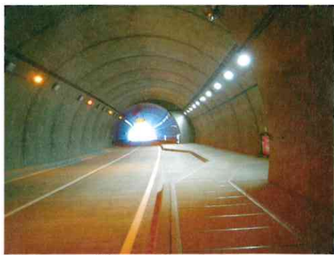
避難路としての機能をもつ三豊トンネル
