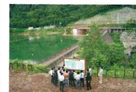
桂沢ダムを視察
