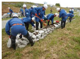
越水防止工法 （積土のう工）
