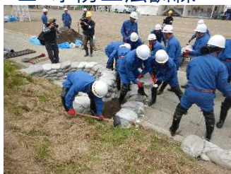
漏水対策工法 （月の輪工）
