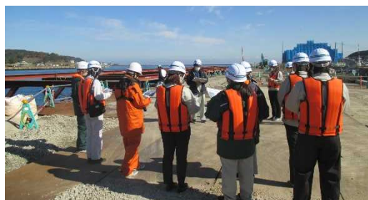
岸壁工事現場視察の様子
