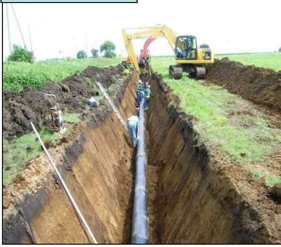
用水路の整備状況
