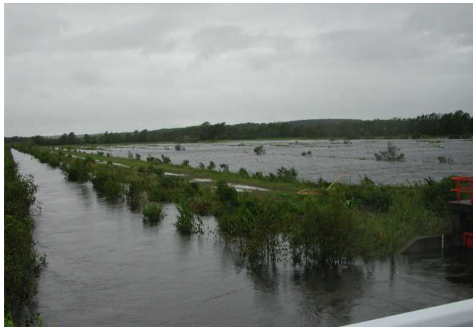
第五清丸別排水路(整備前) ～H13.9台風15号
