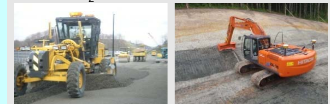
(車道路盤施工状況)
