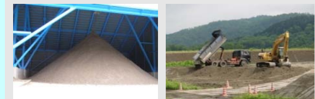
(脱水ケーキ堆積状況)
