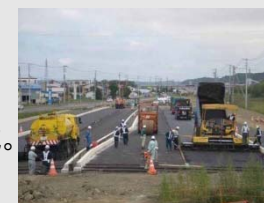
(中温化舗装施工状況)
