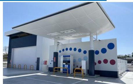
とちぎ水素ステーション
