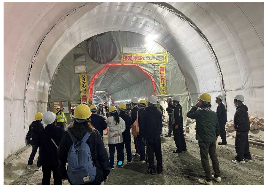
苫前トンネル工事見学会の様子（R7. 10）
