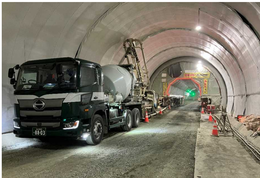
覆工コンクリート打設状況（R7. 10）
