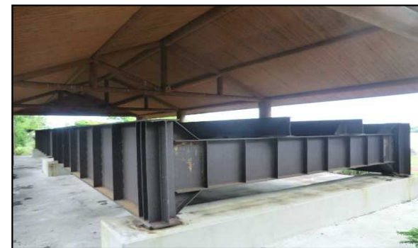
旧運河橋 (2019年度 土木学会選奨土木遺産)
