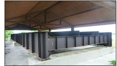
旧運河橋 (2019年度 土木学会選奨土木遺産)
