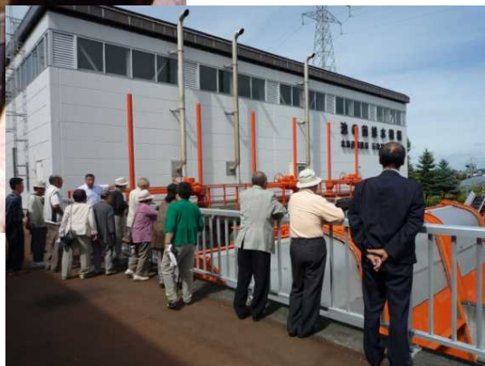
（隣接する池の前排水機場）
