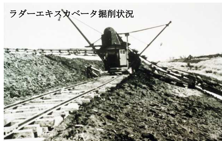
運河掘削中の「しのつ号」
