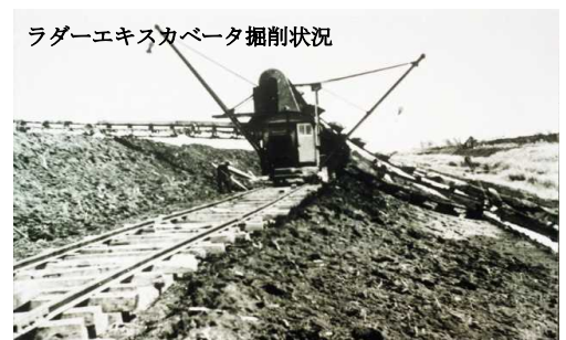
運河掘削中の「しのつ号」
