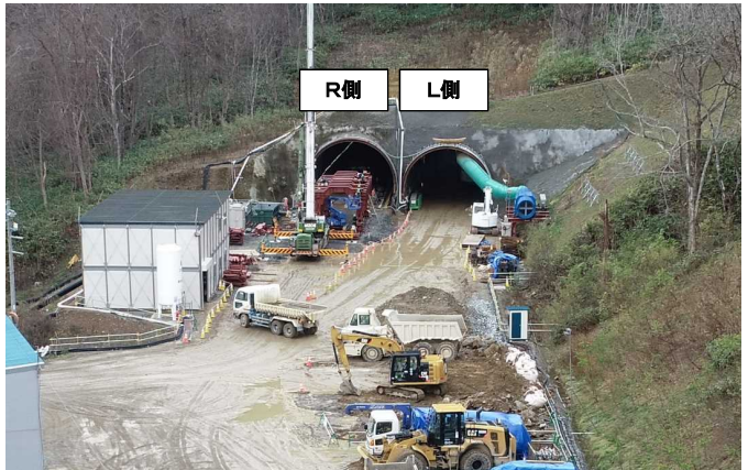
新稲穂トンネルL側共和工区 坑口付近全景 (R5, 11)
