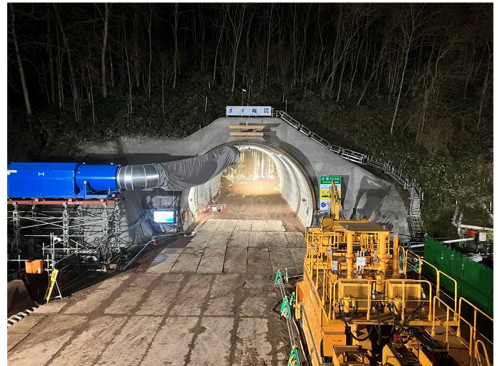
オオヌマトンネル西大沼工区坑口付近全景(R5.11)
