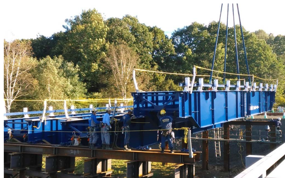
復旧状況【昼間】 ～クレーンによる仮橋設置状況～
