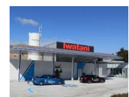
オフサイト型の例 イワタニ水素ステーション宮城仙台
