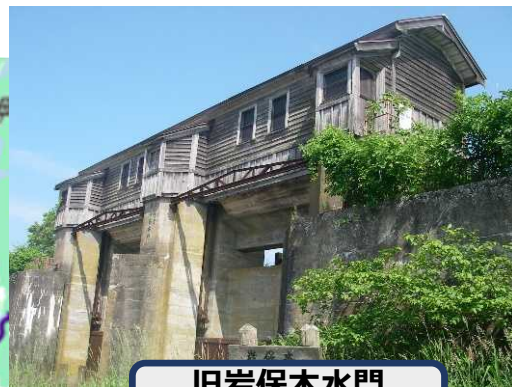
旧岩保木水門 (内部見学有り)
