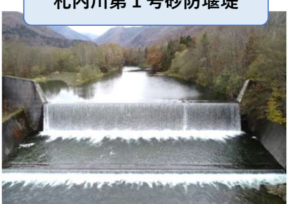
札内川第1号砂防堰堤
