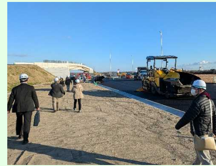
道東自動車道釧路西IC工事現場を職員の解説付きで見学
