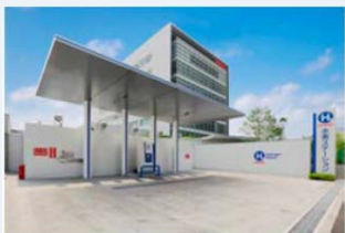
水素ステーション
