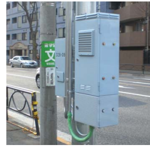
信号機用非常電源
