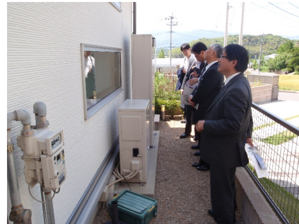
エネファーム設置状況
