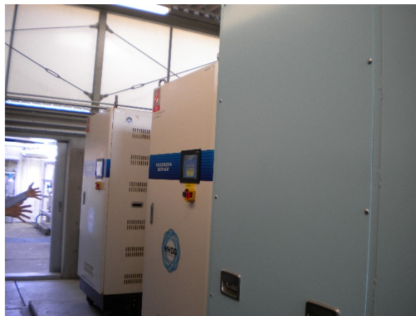
水電解装置(左2台が系統電力、右1台が再エネ電力)
