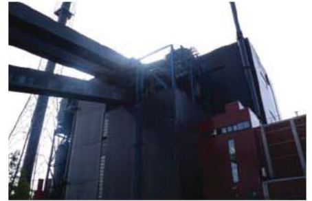
電気・熱回収プラント
