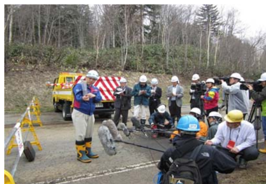
【国道230号中山峠土砂崩れ現地記者レク】
