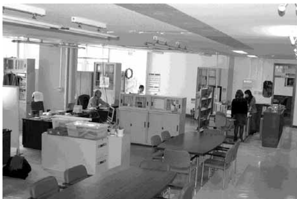
開発建設部本部幹部職員の個室の壁の撤去
