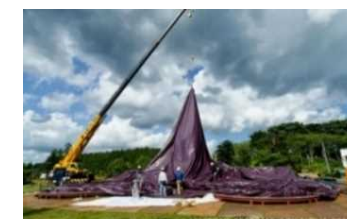
設置中の様子
