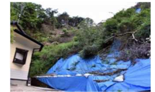
豪雨の度に土砂崩れが多発
