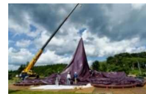
設置中の様子
