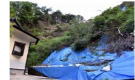
豪雨の度に土砂崩れが多発
