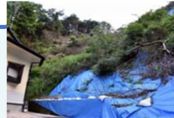
豪雨の度に 土砂崩れが多発
