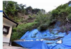
豪雨の度に 土砂崩れが多発
