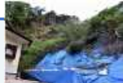
豪雨の度に 土砂崩れが多発
