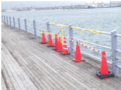
転落防止柵の補修
