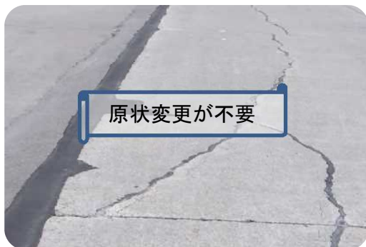
ひび割れ、目地を補修した事例
