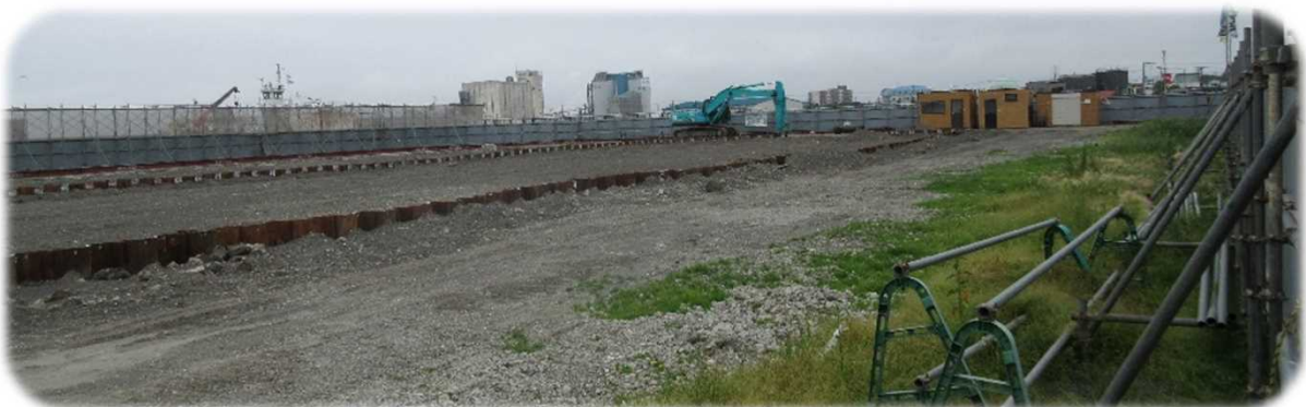
上屋解体工事の現場
