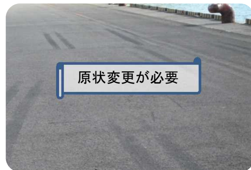
アスファルトで全面施工した事例
