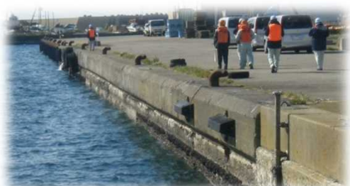
車止めの欠損(左)や防舷材の脱落(右)については、安全確保のため補修が必要
