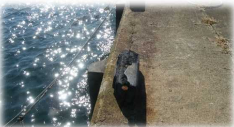
車止めの欠損(左)や防舷材の脱落(右)については、安全確保のため補修が必要
