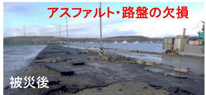
アスファルト・路盤の欠損
