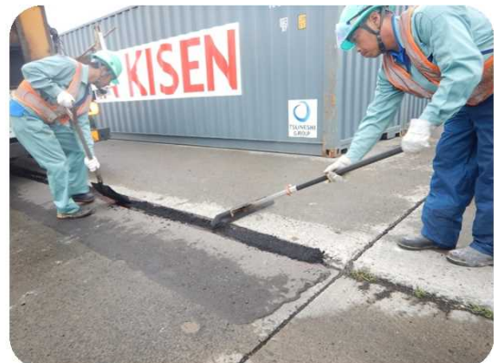
加熱アスファルト敷設状況
