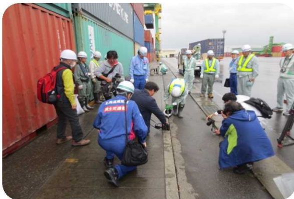
加熱注入式目地材充填状況
