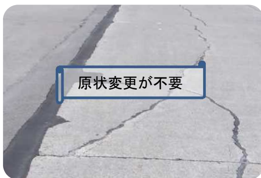
ひび割れ、目地を補修した事例
