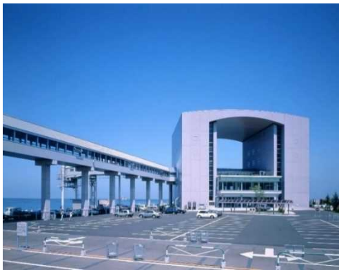
(上写真：小樽フェリーターミナル)
