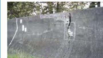
堤防のひび割れ・鉄筋の露出
