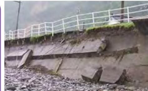
平成19年新潟県中越沖地震における護岸の被災(上輪海岸)
