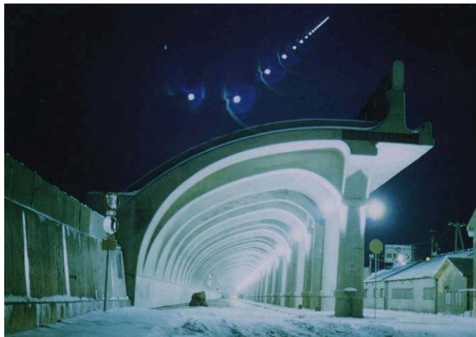
稚内港北防波堤ドーム
